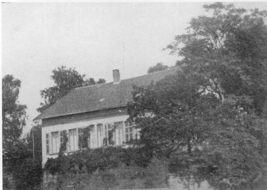
Das alte evangelische Gemeindehaus vor seinem Umbau
